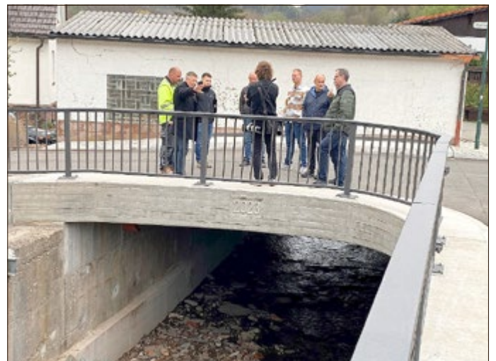
Beim Millionenprojekt Brücke über die Hasel in Unterschöna erfolgte die abschließende Bauabnahme durch die Vertreter der Baufirmen sowie die anschließende Übergabe an die Stadt Steinbach-Hallenberg.
