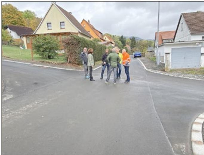
Nach starkem Regen war früher unterhalb der alten Linde eine Problemstelle für den Bauhof. Jetzt ist die Kreuzung Gruppich/An der Lahn nach dem grundhaften Ausbau mit Teerdecke und geordneter Wasserführung komplett neu angelegt geworden.
