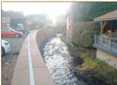
Am Schlossbergplatz wurde die Ufermauer mit Weser Hartsandstein teilweise neu errichtet und saniert. Diese Maßnahme mit Kosten von 250 T€ ist Bestandteil der Umgestaltung des Schlossbergplatzes und wurde durch das Programm Städtebauförderung mit 165 T€ bezuschusst.
