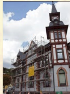
Die Fassade vom Rathaus wurde saniert.
