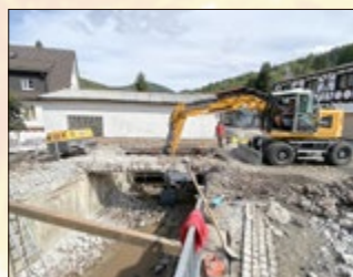
Größtes Bauprojekt im Stadtgebiet gestartet: Die Brücke in Unterschönau
