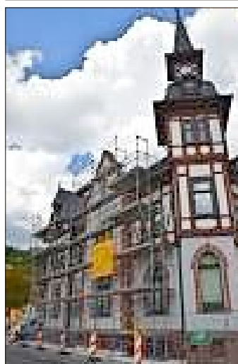
Baugerüst am Steinbach-Hallenger Rathaus
