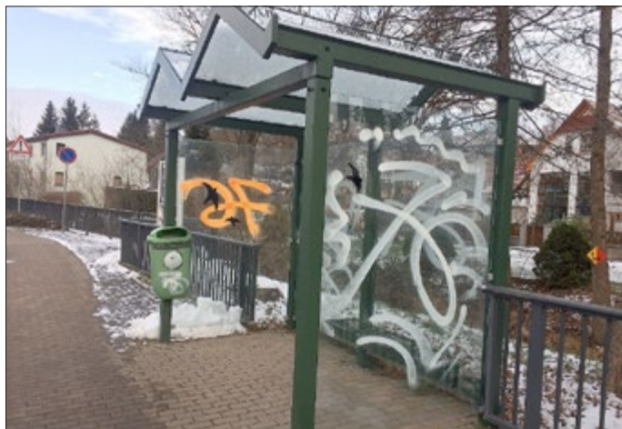
Ähnlich wie hier an der Hergeser Bushaltestelle, wurden an rund 60 Stellen zwischen Herges-Hallenberg und Viernau auffällige Schmierereien hinterlassen.
